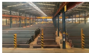
Centro stoccaggio lavorazioni travi, Sipre
